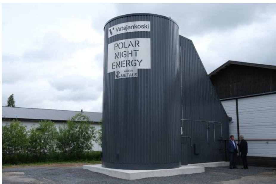
Slika 6 Visokotemperaturni toplinski spremnik punjen pijeskom [8]
