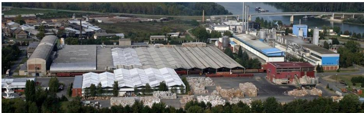
Slika 14. Pogon tvornice DS Smith u Belišću [61]
