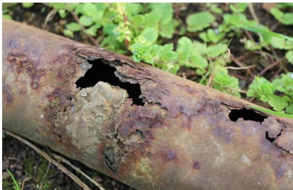
Slika 4. Cijev korištena u postrojenju za pročišćavanje otpadnih voda [11]
