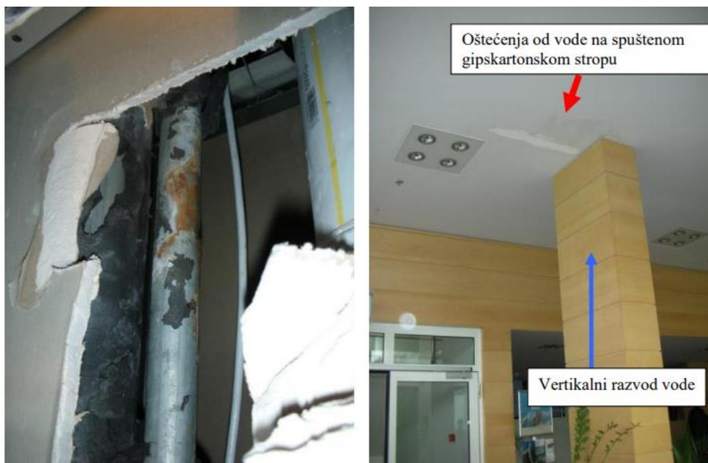
Slika 9. Prikaz oštećenja – propuštanje vode i oštećivanje objekta [10]
