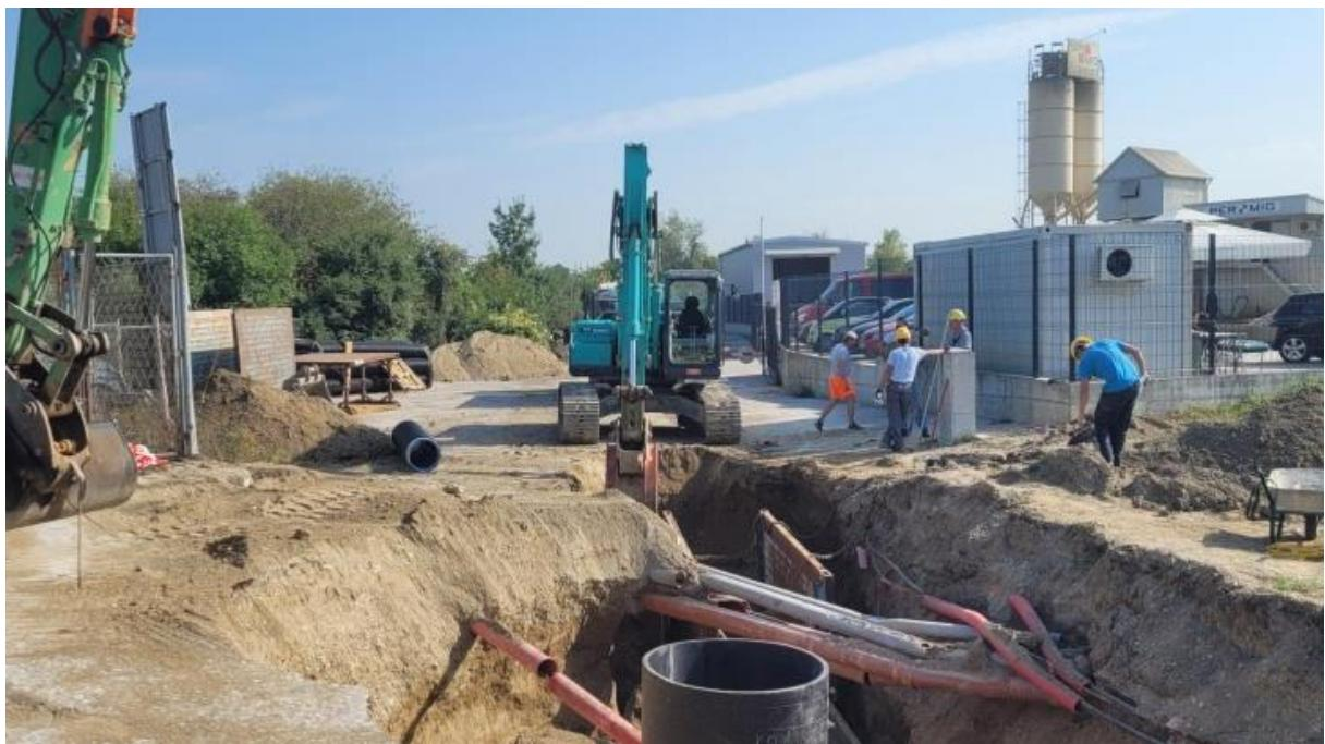
Slika 16. Radovi na izgradnji javnog kanala sanitарне i oborinske odvodnje [35]
