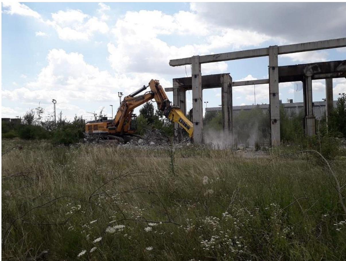
Slika 15. Radovi na uklanjanju postojećih građevina [34]
