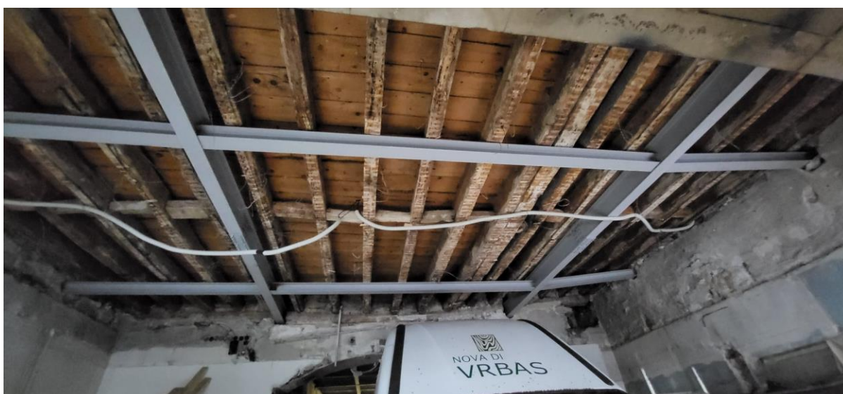
Slika 78 : Prikaz gotove konstrukcije
