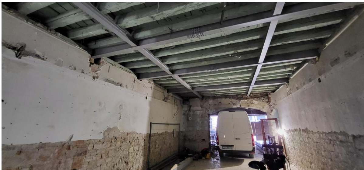
Slika 77 : Prikaz gotove konstrukcije
