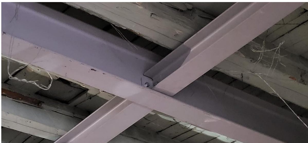
Slika 80 : Prikaz spoja između IPE i HEA profil
