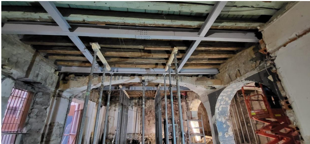
Slika 79 : Prikaz gotove konstrukcije
