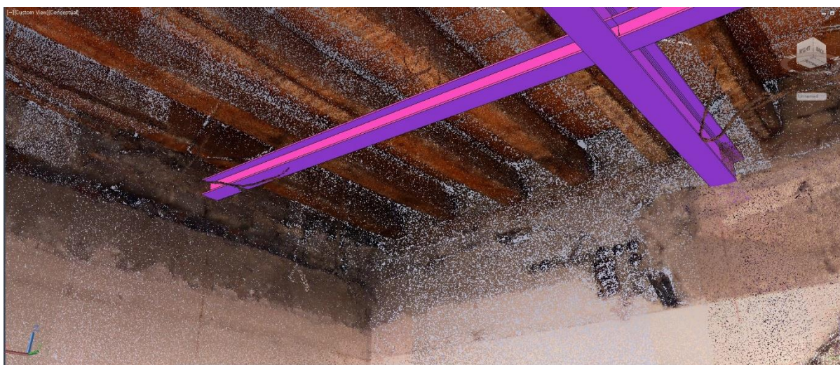
Slika 41 : Prikaz podudarnosti čelične konstrukcije s oznakom na zidu
