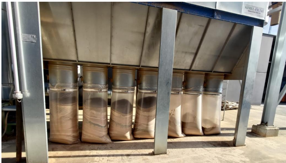
Slika 14. Sitna piljevina prikupljena filtracijom
