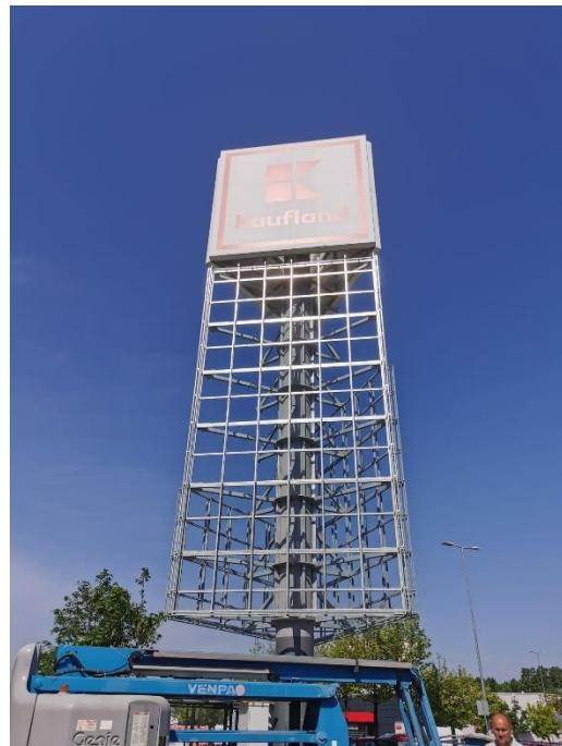
Slika 16. Konstrukcija zaštićena alkidnim premazima
