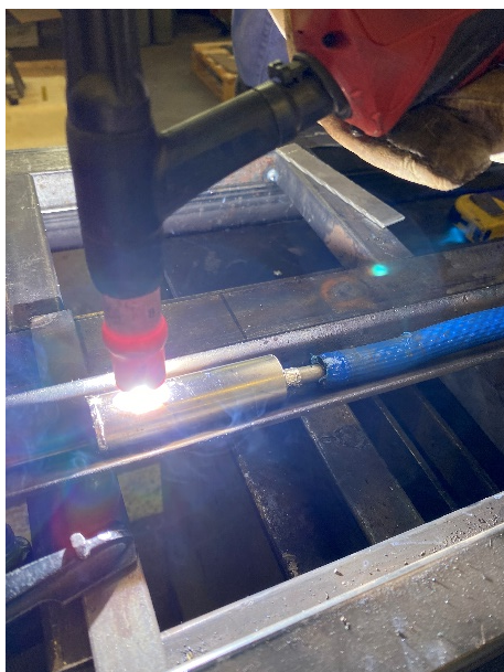
Slika 54 Navarivanje uzoraka
