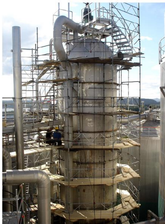
Slika 10. Reaktor vodikovog peroksida izrađen 2006. god. od dupleks čelika LDX 2101 [16]
