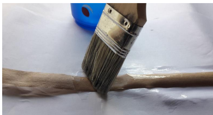
Slika 93. Drugi način - nanošenje ljepila pomoću kista
