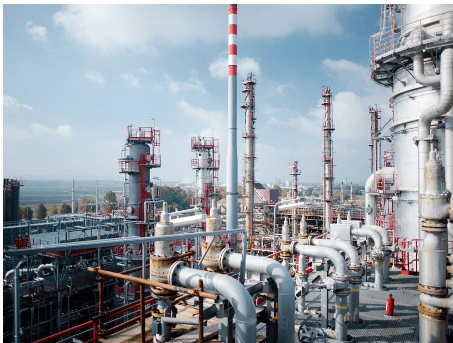
Slika 2. Primjer procesnog postrojenja – naftna rafinerija [5]
