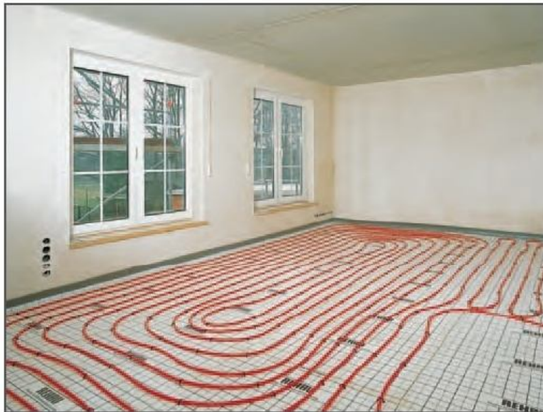
Slika 6. Primjer izvedbe Rehau Tacker sustava
