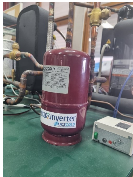
Slika 10. Odvajač ulja
