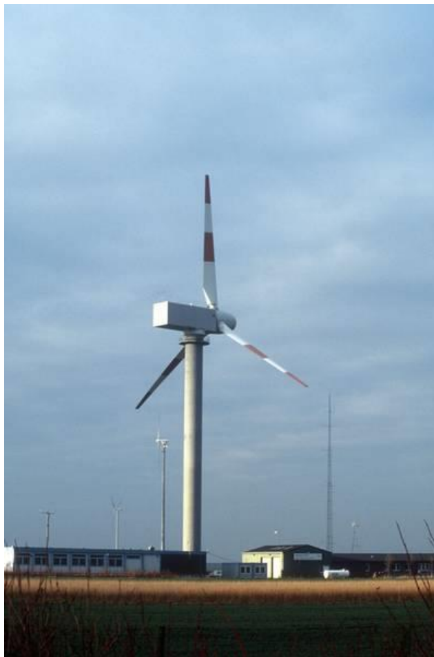
Slika 22. Vjetroturbina MAN WKA-60 (1,2 MW) [30]
