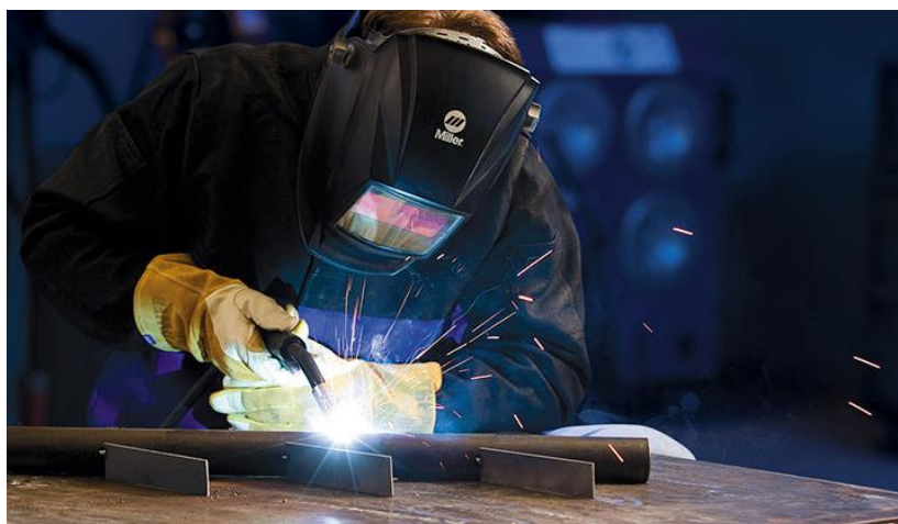
Slika 1: Postupak MIG zavarivanja [3]
