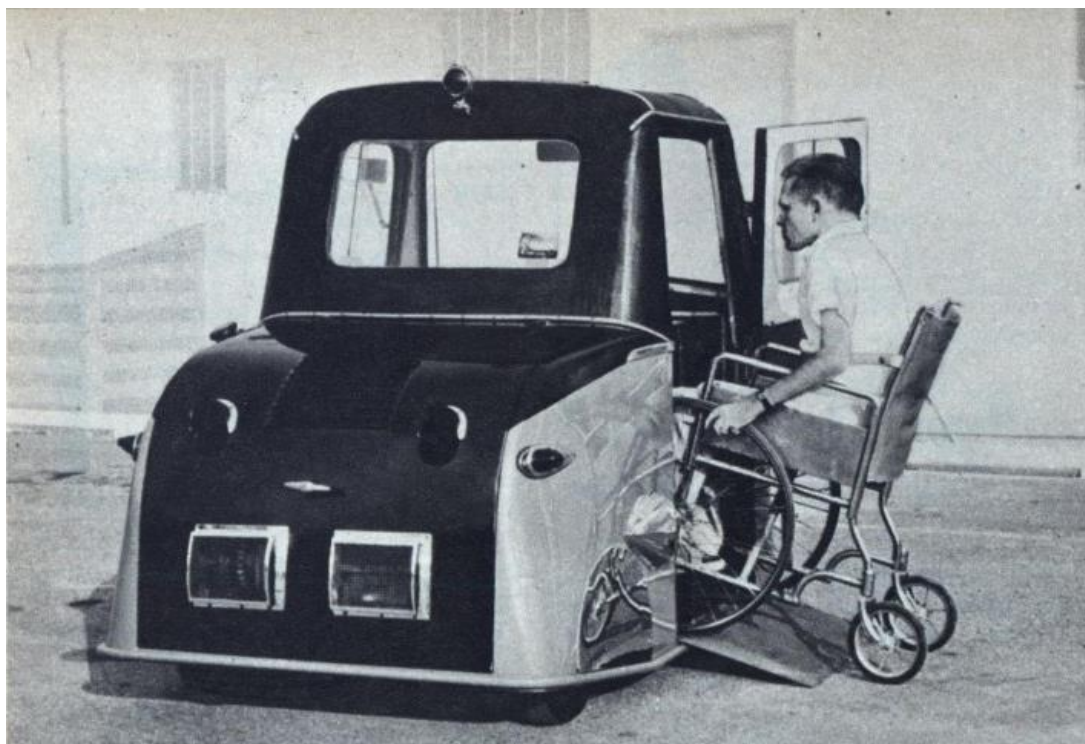
Slika 2. Cestovno vozilo za prijevoz osoba u invalidskim kolicima [1]
