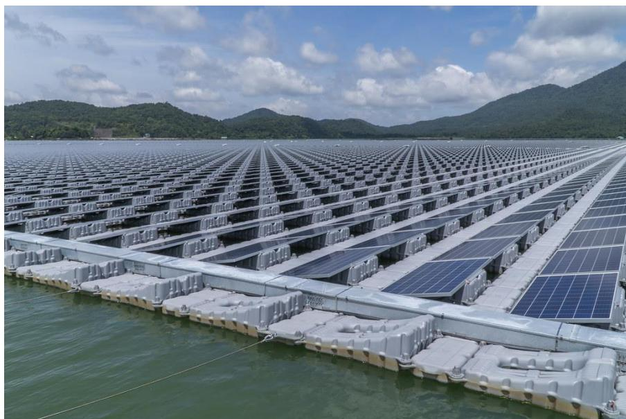
Slika 10. Pontonska konstrukcija sustava FPV [40]
