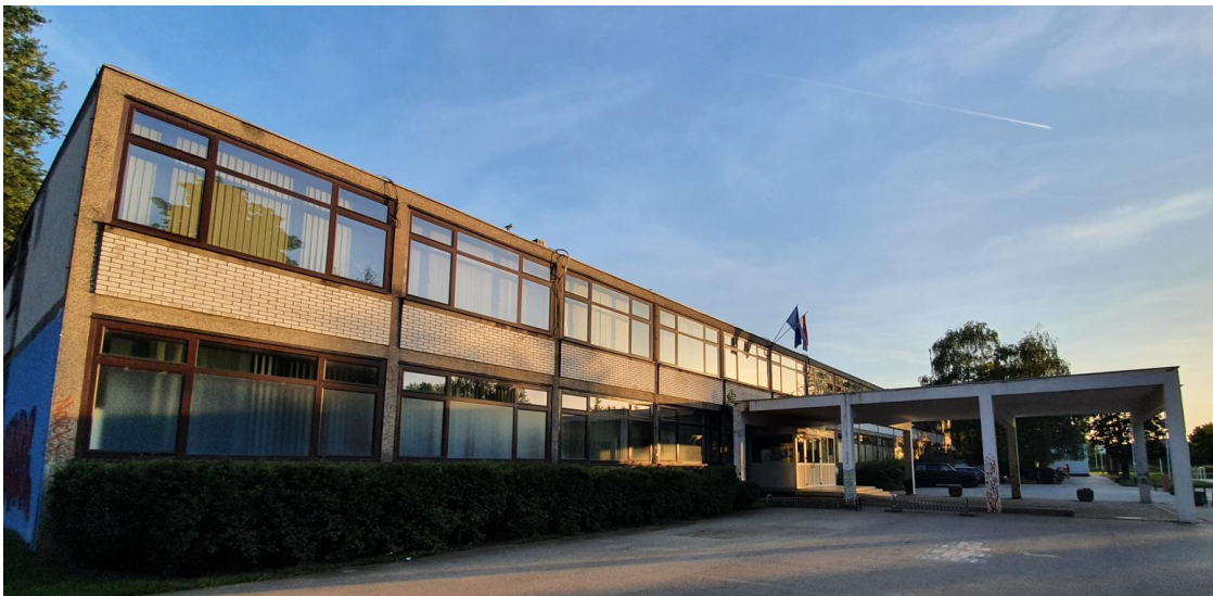
Slika 36. Zgrada OŠ Trnsko korištena za analizu točnosti UMI simulacija potrošnje energije
