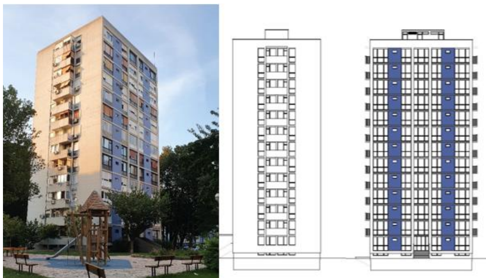
Slika 48. Stambena zgrada Trnsko 24 [9]
