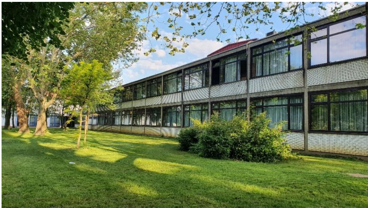
Slika 3. Južno pročelje Osnovne škole Trnsko
