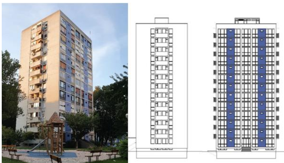
Slika 48. Stambena zgrada Trnsko 24 [9]
