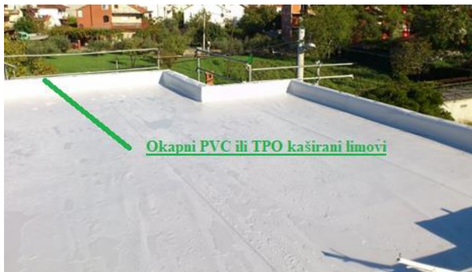
Slika 1. Primjer ravnog krova izvedenog PVC hidroizolacijskom membranom
