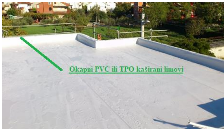
Slika 1. Primjer ravnog krova izvedenog PVC hidroizolacijskom membranom
