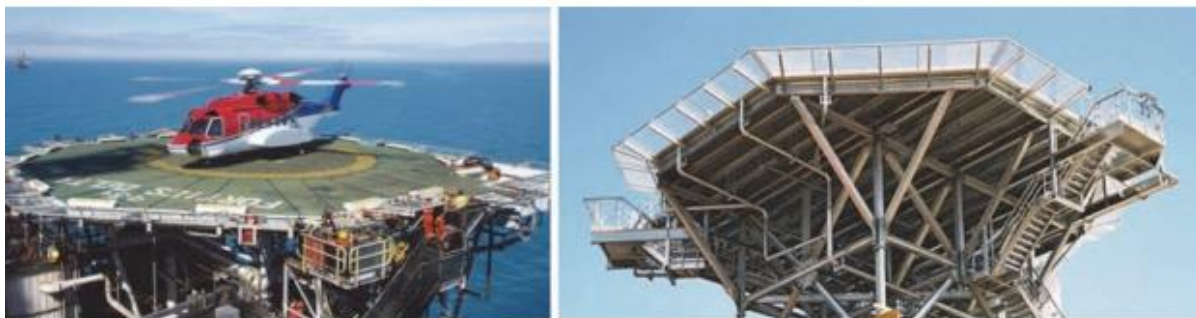
Slika 6. Platforme za helikoptere [4]
