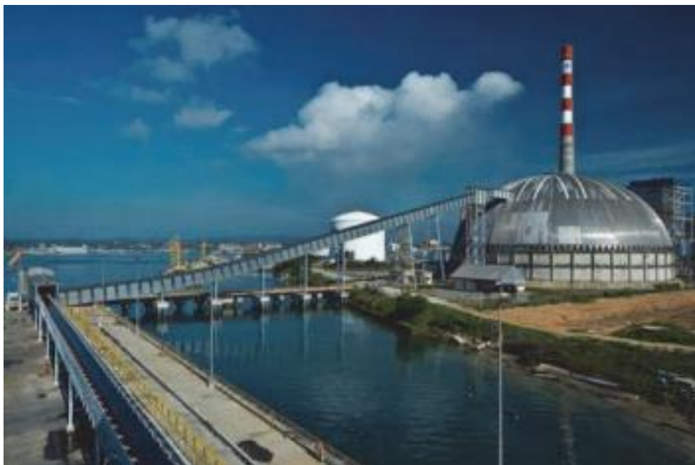
Slika 5. Aluminijska kupola za skladištenje ugljena [4]
