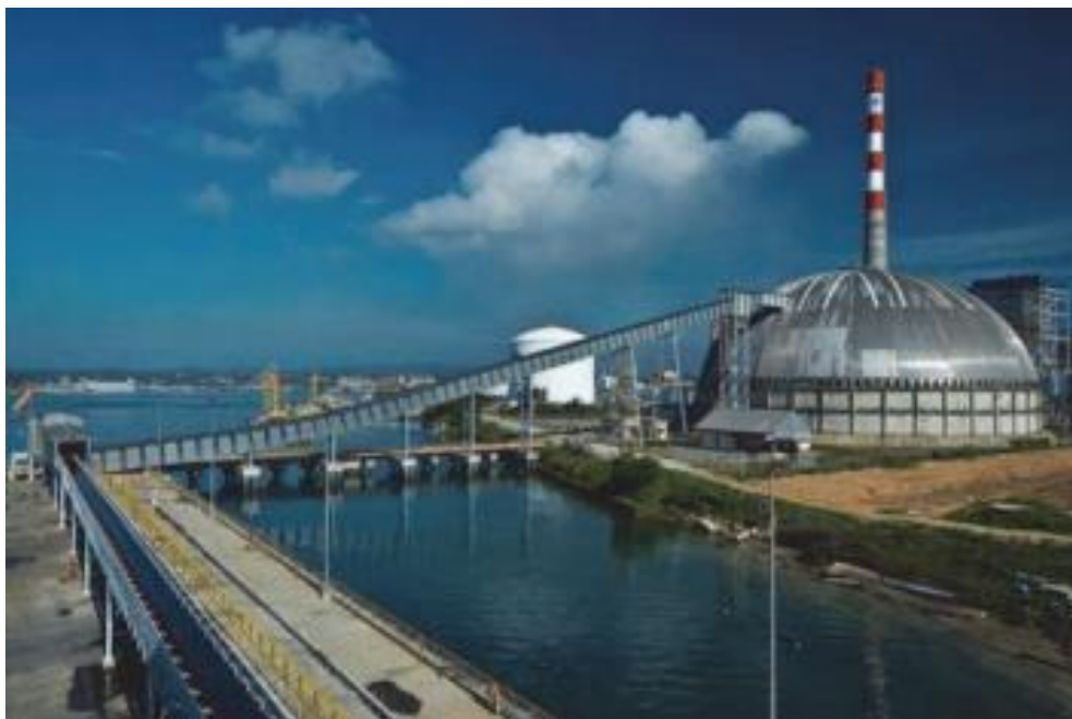
Slika 5. Aluminijaska kupola za skladištenje ugljena [4]
