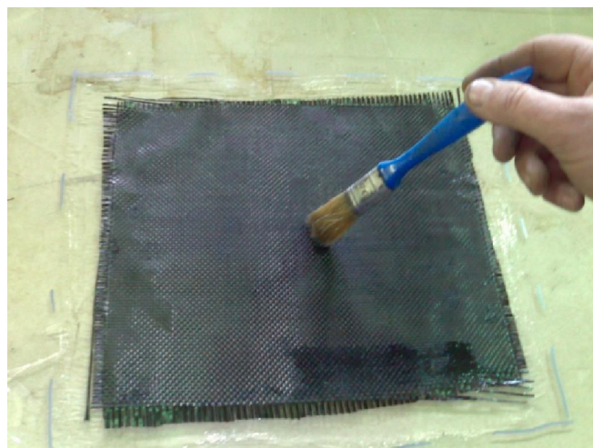
Slika 27 Početak impregniranja prvoga sloja ugljičnih vlakana
