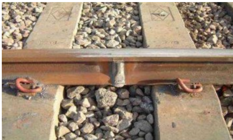
Slika 3. Prikaz tračnica zavarenih aluminotermijskim postupkom [12]
