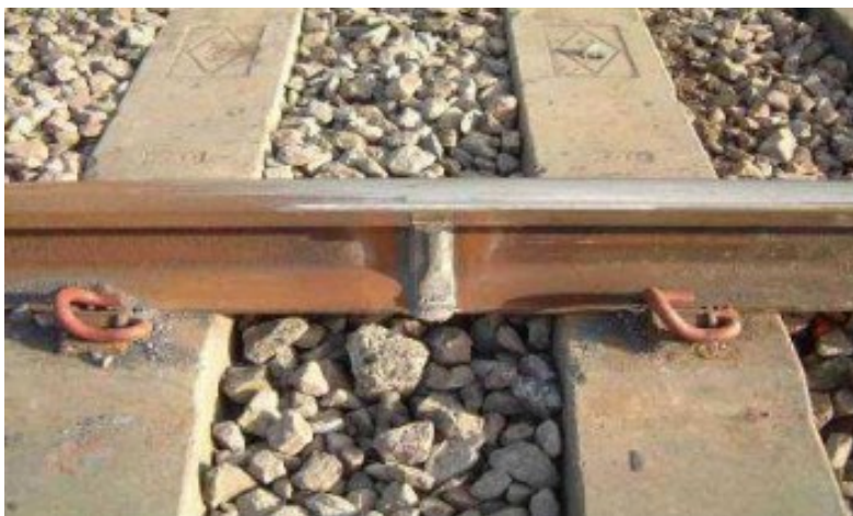
Slika 3. Prikaz tračnica zavarenih aluminotermijskim postupkom [12]
