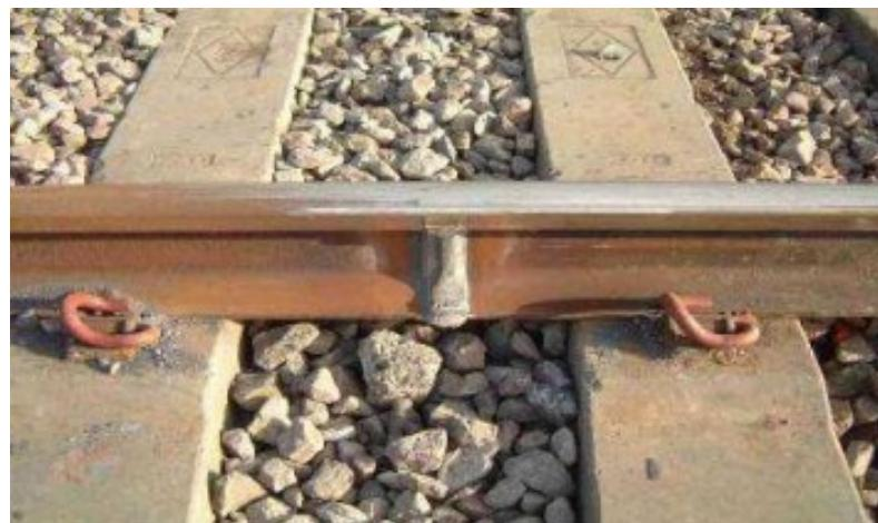
Slika 3. Prikaz tračnica zavarenih aluminotermijskim postupkom [12]
