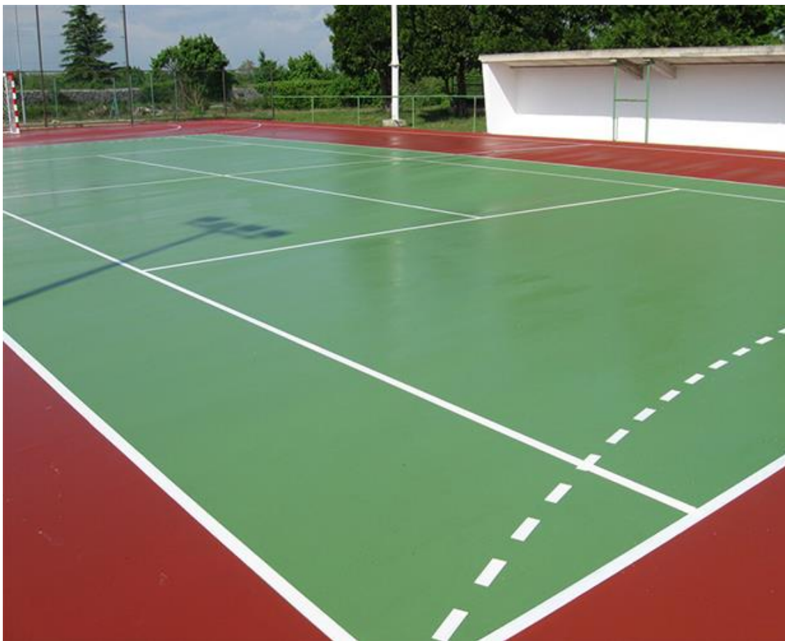
Slika 5. Akrilni premazi na sportskom terenu [17]
