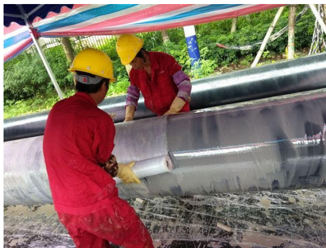
Slika 16. Oblaganje cijevi staklenim vlaknima [26]
