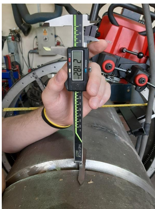
Slika 44. Dubina žlijeba nakon zavarivanja korijena epruvete V-1
