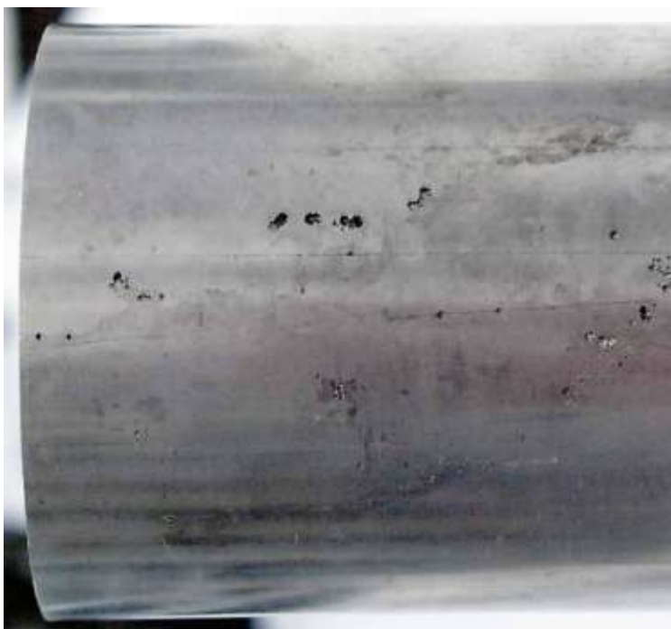
Slika 21. Jamičasta korozija na vanjskoj površini cijevi [1].
