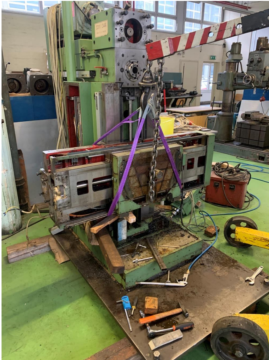
Slika 40. Demontaža suporta X osi
