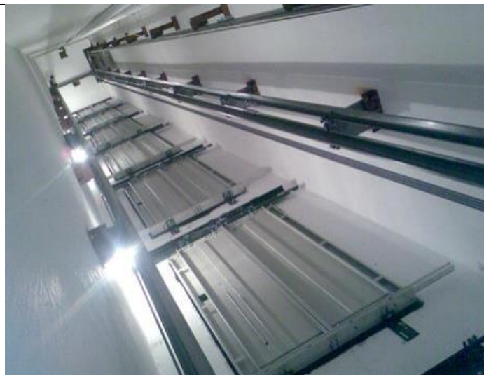
Slika 28. Vozno okno čvrste konstrukcije [3]
