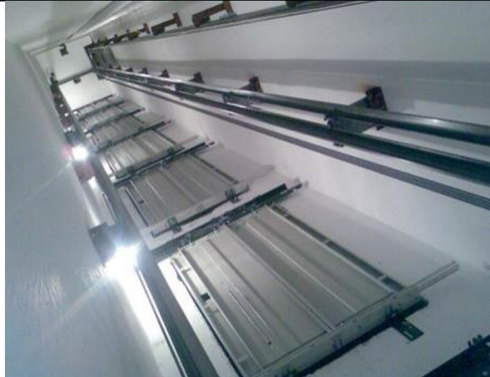
Slika 28. Vozno okno čvrste konstrukcije [3]
