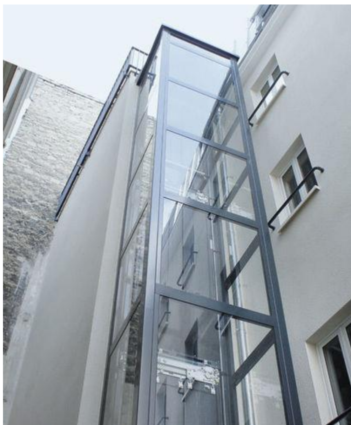
Slika 30. Vozno okno metalne nosive konstrukcije [6]
