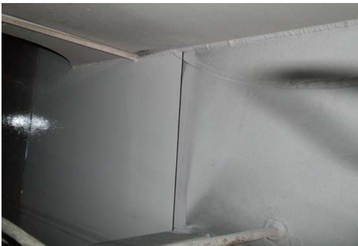
Slika 75. Razlika između Hempadura 15570 i Hempasila 77500 (lijevi dio slike), Brodogradilište Uljanik, Pula
