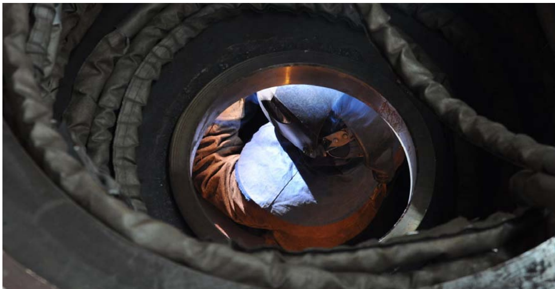
Slika 54. Detalji unutarnjeg zavarivanja odljevka, Brodogradilište Uljanik, Pula, svibanj 2010.
