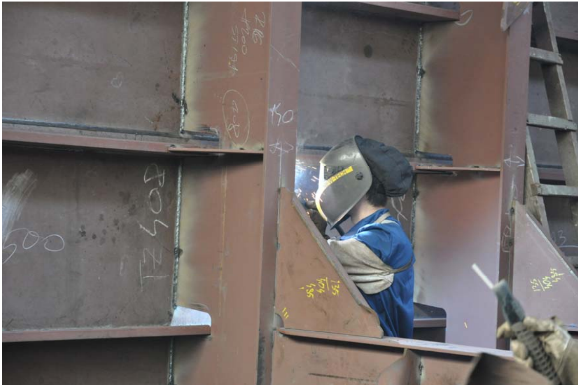
Slika 30. Zavarivanje kutnih spojeva REL postupkom, detalj iz Brodogradilište Uljanik, Pula, svibanj 2010.
