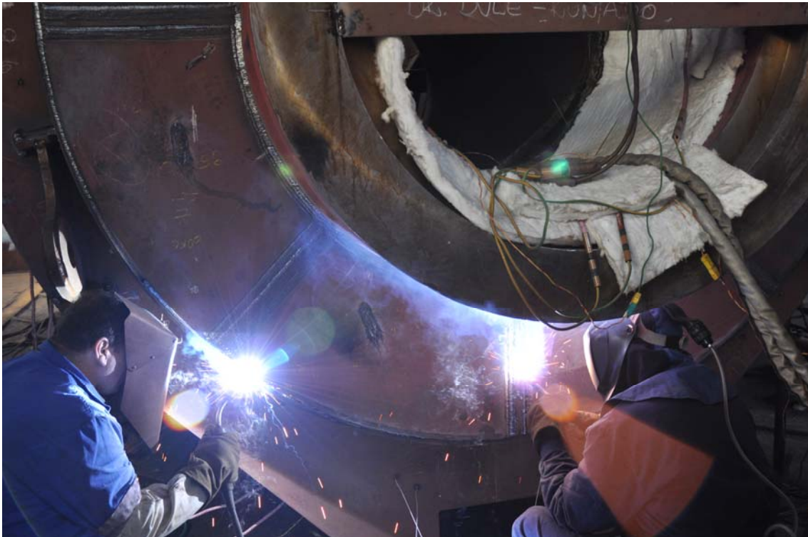
Slika 29. Zavarivanje REL i MIG postupkom, gdje se zavaruje „glava” kopača praškom punjenom žicom Ø 1.2 mm, te elektrodom Ø 5 mm. Debljina materijala koji se zavaruje je 30 mm, te se za te debljine koristi žica i elektroda koje sadrži veći postotak nikla radi bolje zavarljivosti. Prilikom zavarivanja, lim se predgrijava elektro – induktivnim predgrijavanjem na temperaturu od 160°C , Brodogradilište Uljanik, Pula, svibanj 2010.
