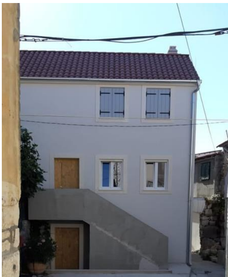
Slika 5. Zapadna fasada kuće
