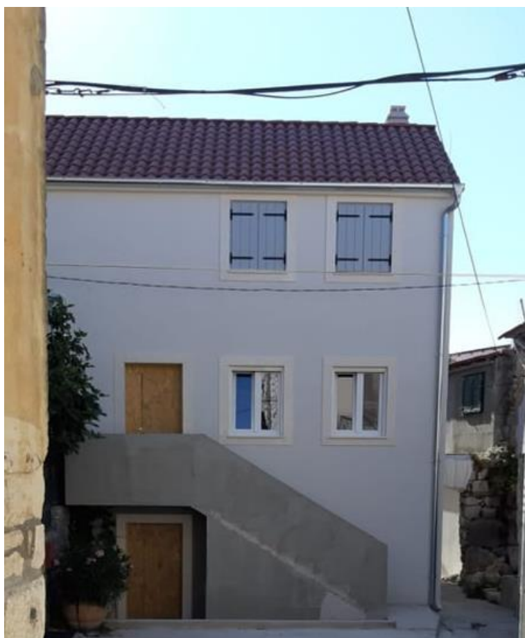
Slika 5. Zapadna fasada kuće
