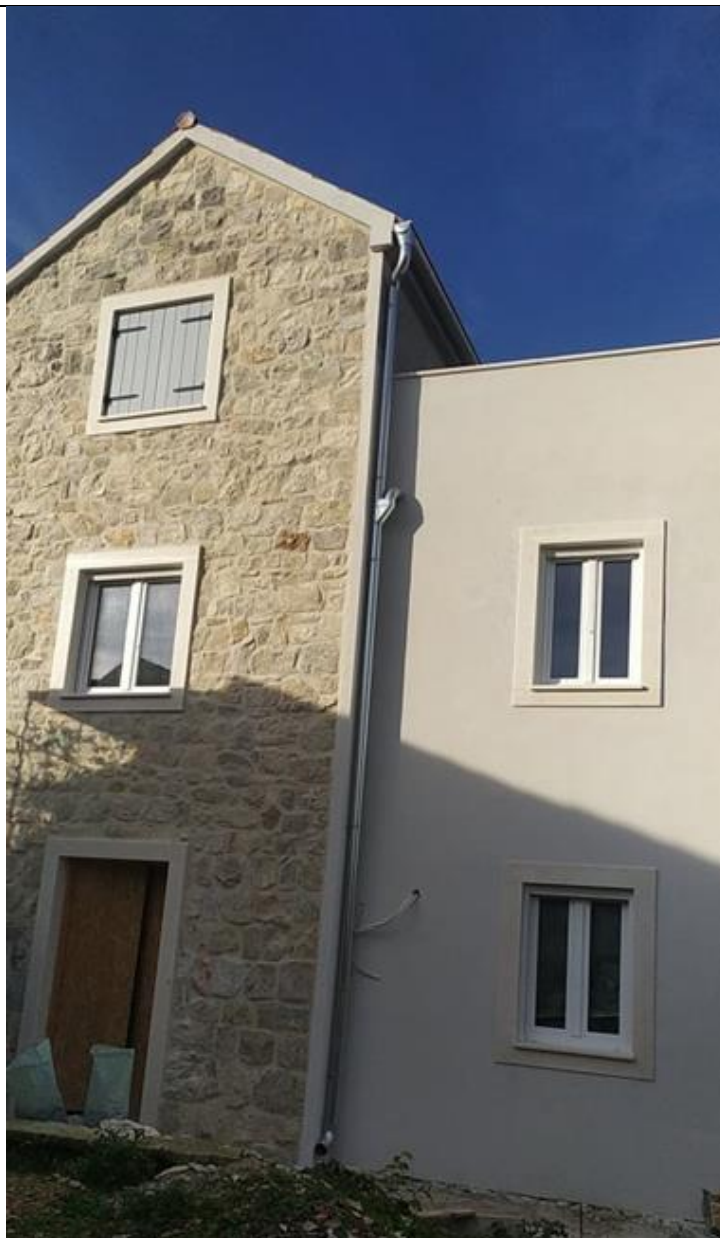
Slika 6. istočna fasada kuće
