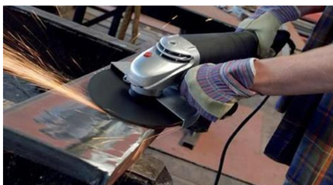
Slika 9. Prikaz mehaničke obrade zavara brušenjem [13]
