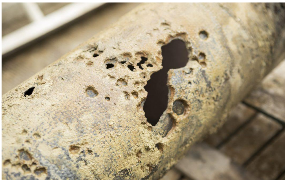
Slika 13. Primjer rupičaste korozije [18]
