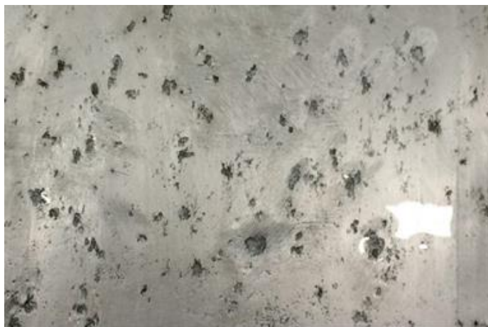
Slika 15. Rupičasta korozija aluminija [24]
