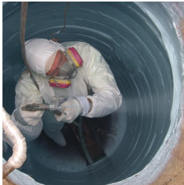
Slika 11. Nanošenje poliuree unutar cijevi. [26]
