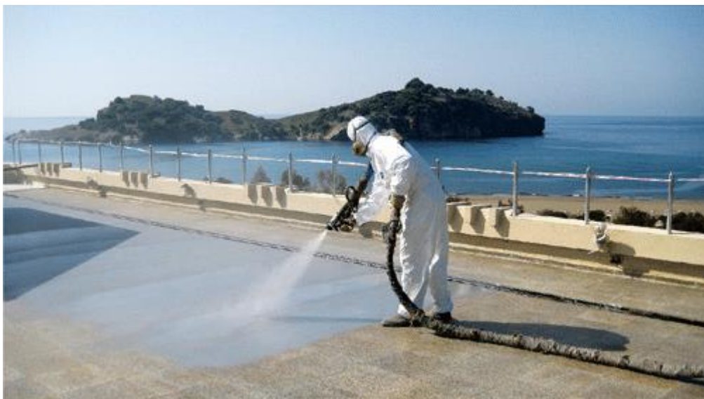
Slika 13. Nanošenje poliuree na betonski most. [28]
