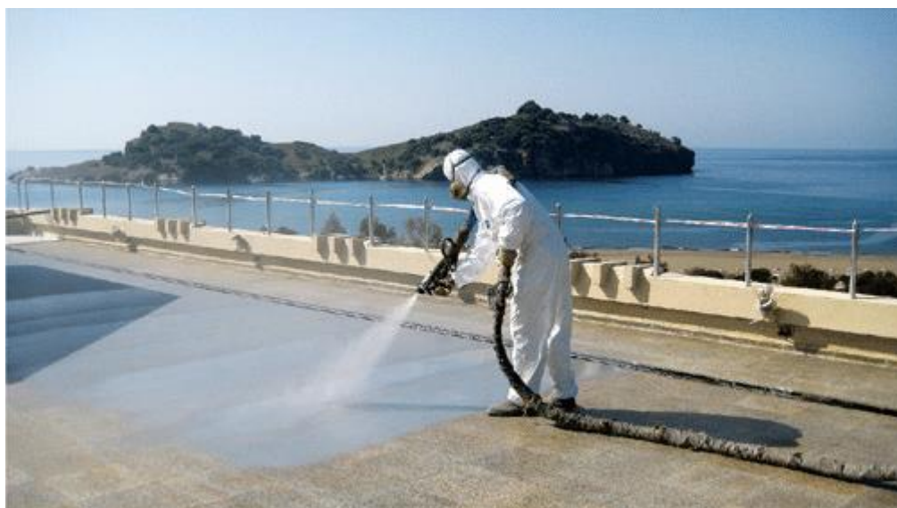
Slika 13. Nanošenje poliuree na betonski most. [28]
