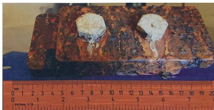
Slika 2. Galvanska korozija između vijka i ploče [7]
