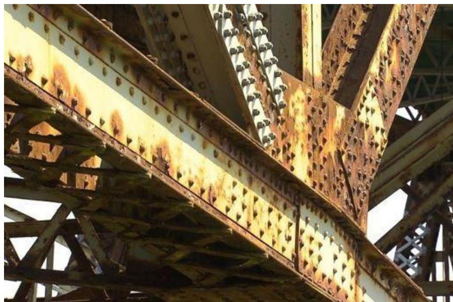
**Slika 14. Atmosferska korozija čelične konstrukcije mosta [16]**
