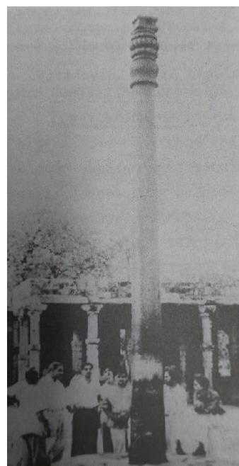
**Slika 12. Kutub-stup od lijevanog željeza star 1700 godina [2]**
