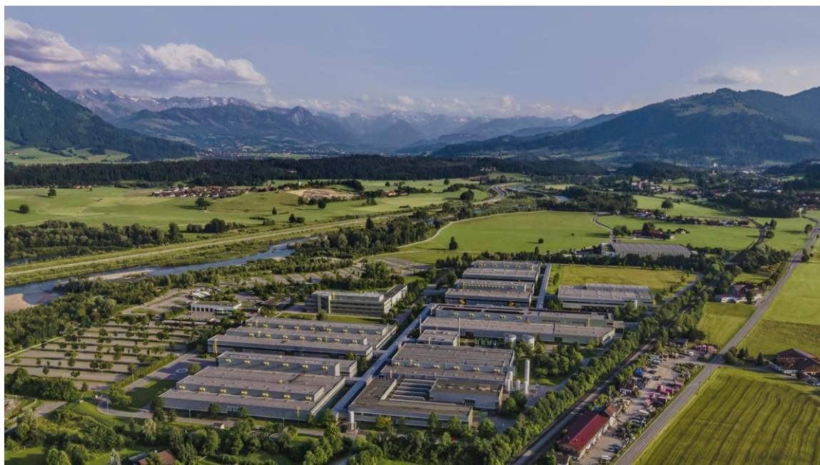
Slika 16. Boschova inovativna tvornica, Blaichach [18]
