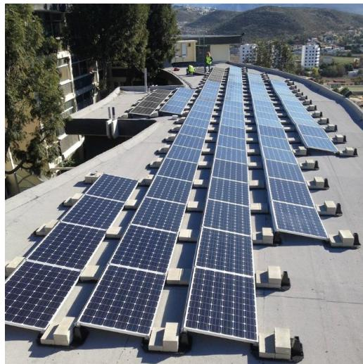
Slika 10 Sistem sa balastom [12]
