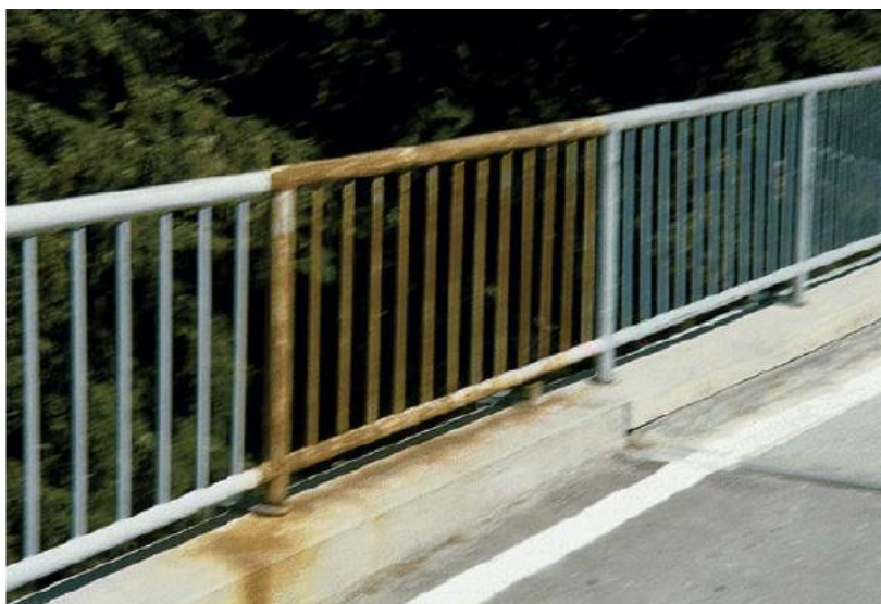
Slika 1. Opća korozija [5]
