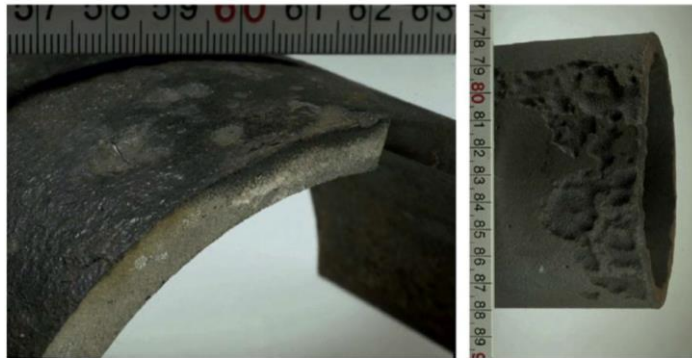
Slika 6. Selektivna korozija – grafitizacija [5]
