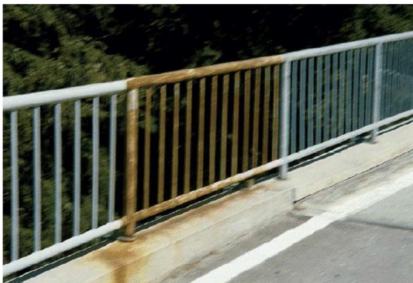
Slika 1. Opća korozija [5]
