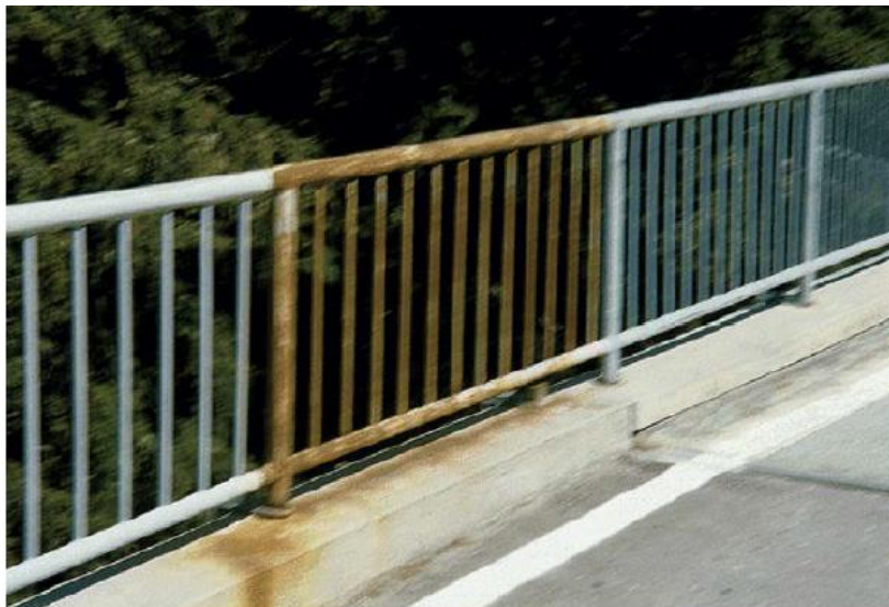
Slika 1. Opća korozija [5]
