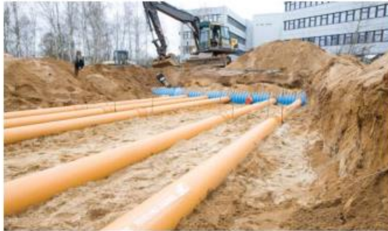
Slika 1. Primjer sustava s izmjenjivačem topline zemlja-zrak kod sjedišta tvrtke REHAU, Erlangen, Njemačka [3]
