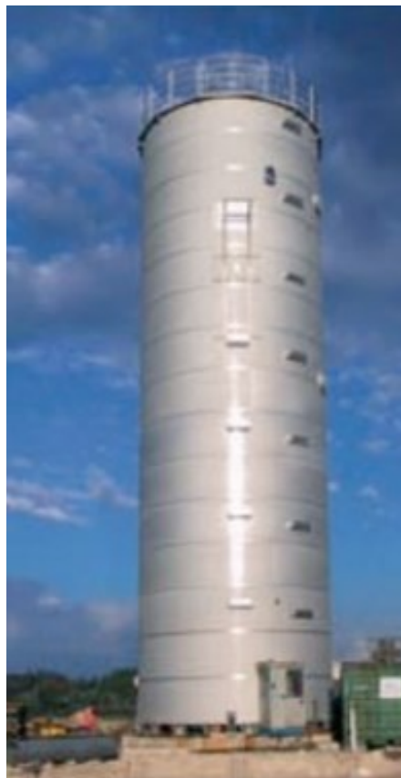
Slika 15. Spremnik za etanol od dupleks nehrđajućeg čelika [18]
