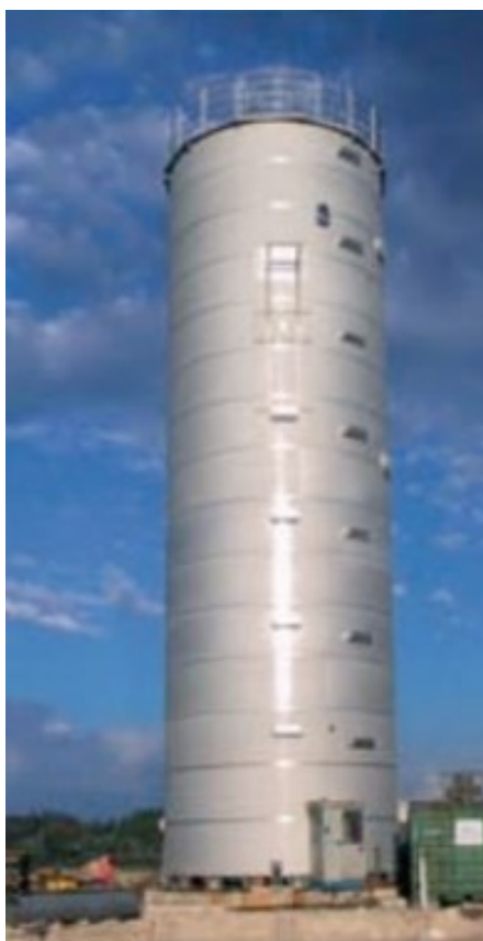
Slika 15. Spremnik za etanol od dupleks nehrđajućeg čelika [18]
