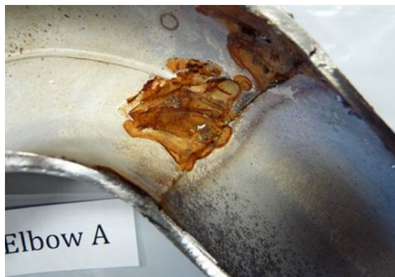
Slika 8. Korozija u procjepu čelika [15]
